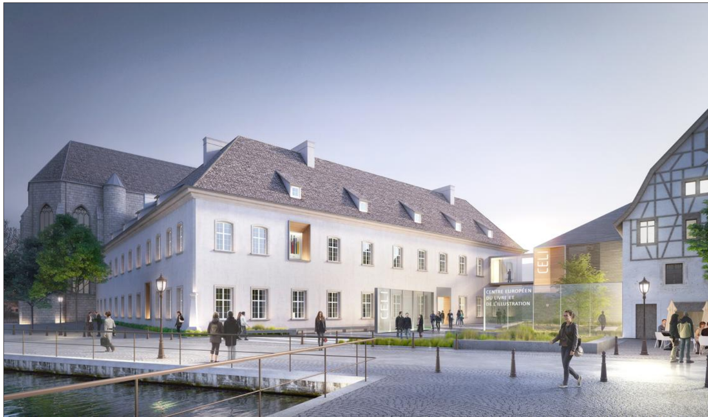
On voit sur cette image le parvis ; l'entrée décalée sur la gauche ; le bâtiment moderne en verre et bois qui se substituera à l'actuelle annexe, et la galerie suspendue entre les deux bâtiments. DR
